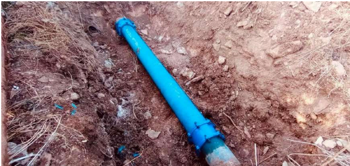
La tubería que ha sido sustituida. / E. S.
