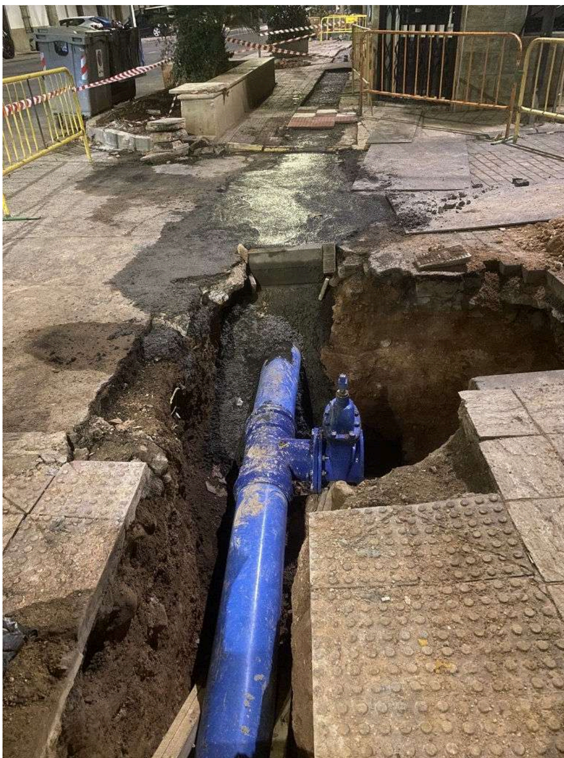
Bolaños de Calatrava invierte 2,5 millones en renovar tuberías para garantizar el suministro de agua
