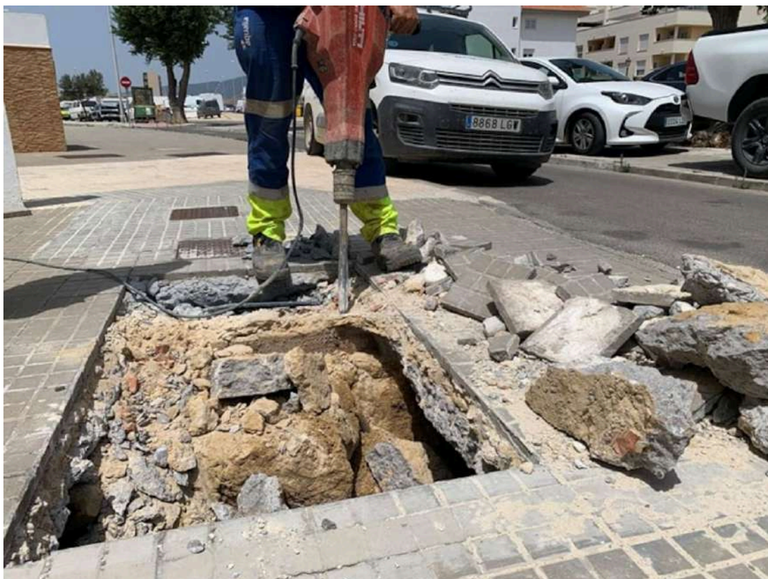
Trabajos de reparación en Tarifa / RA
