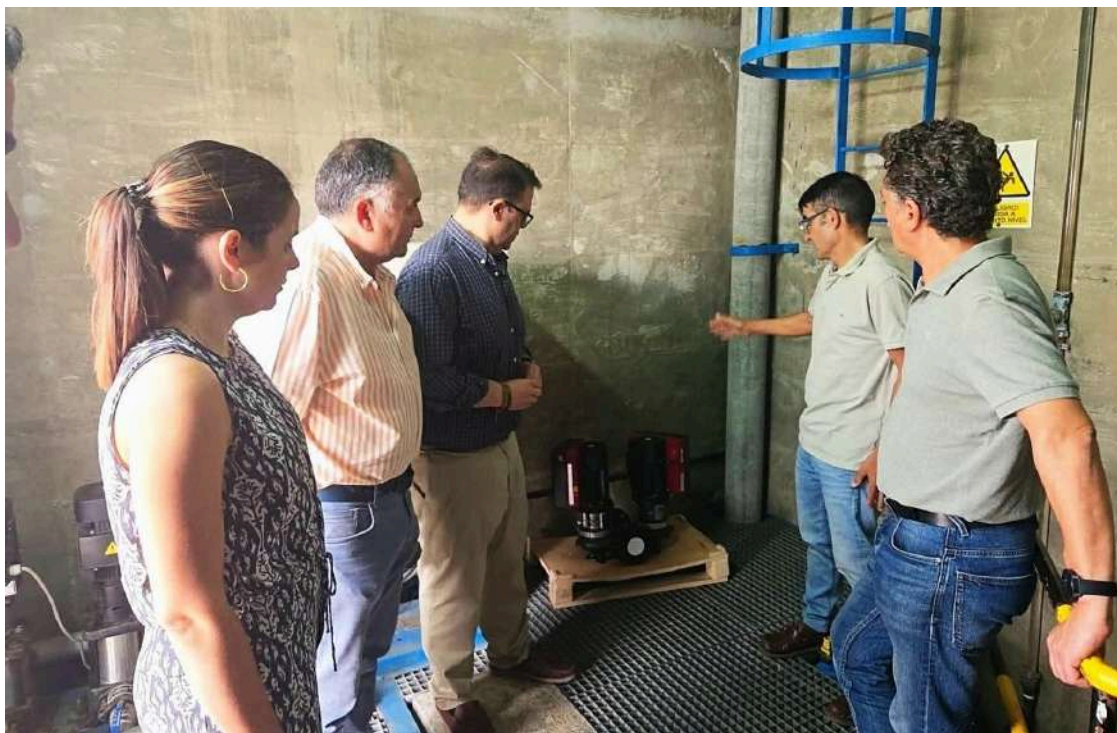
Visita a los trabajos que se han realizado en Salobreña
