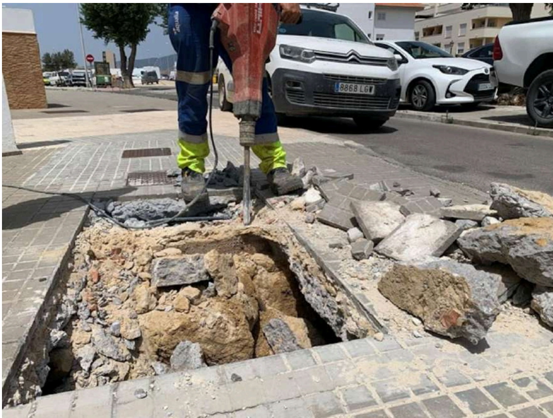
Trabajos de reparación en Tarifa / RA
