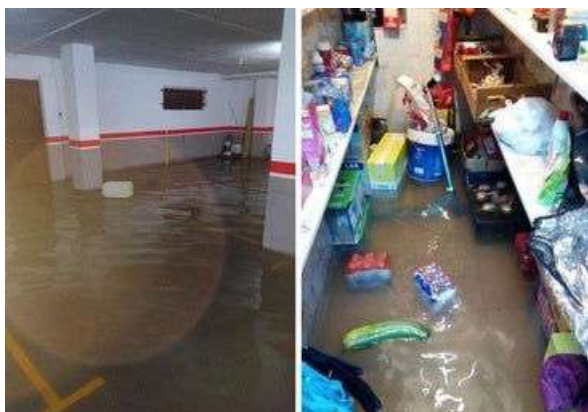
UPL denuncia al alcalde de Valverde la Virgen por «haberse desentendido de la inundaciones provocadas por un colector en mal estado»
