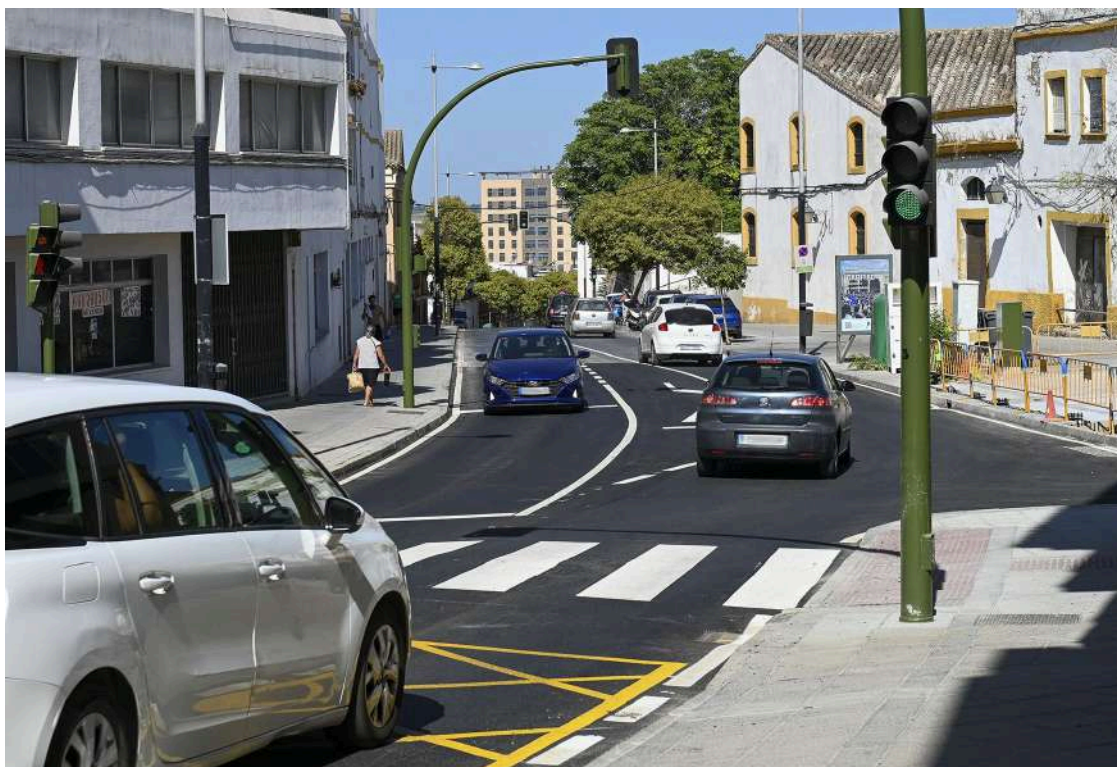
Obras en la ronda Muleros.
